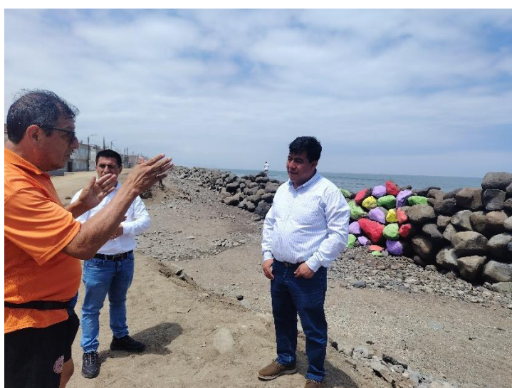
Foto N° 03: RECORRIDO POR EL BORDE COSTERO, CONSTATANDO LOS EFECTOS DE LA EROSIÓN Y LAS CONDICIONES DE LAS ZONAS AFECTADAS
