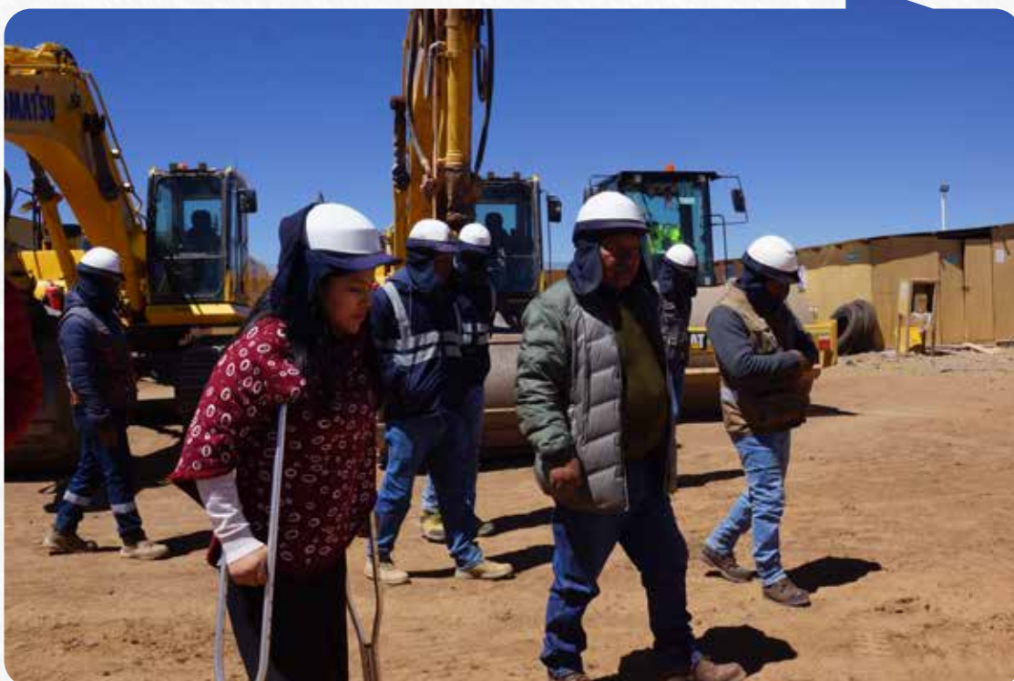
Foto 6. Fiscalización, junto al supervisor de la obra de la carretera Achaya–Arapa.
