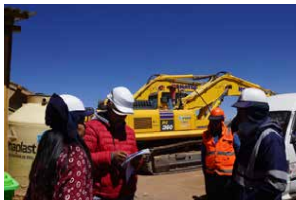
Foto 7. Fiscalización, junto al supervisor de la obra de la carretera Achaya–Arapa.
