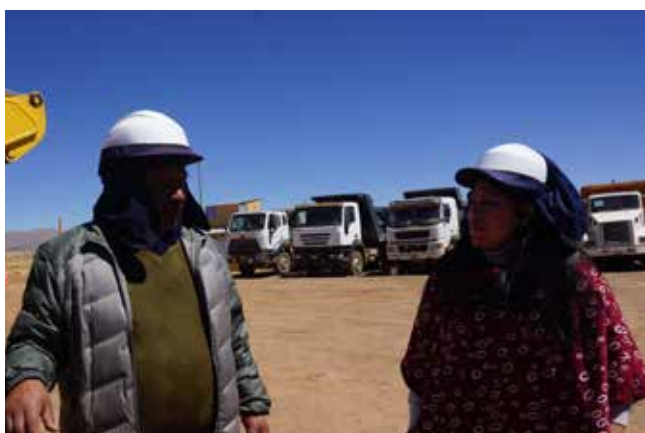
Foto 8. Fiscalización de maquinaria in situ de la cantera Arapa de la obra.
