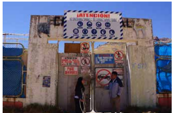
Foto 15. Fiscalización de la obra Coliseo Cubierto “Club del Pueblo Salcedo”.
