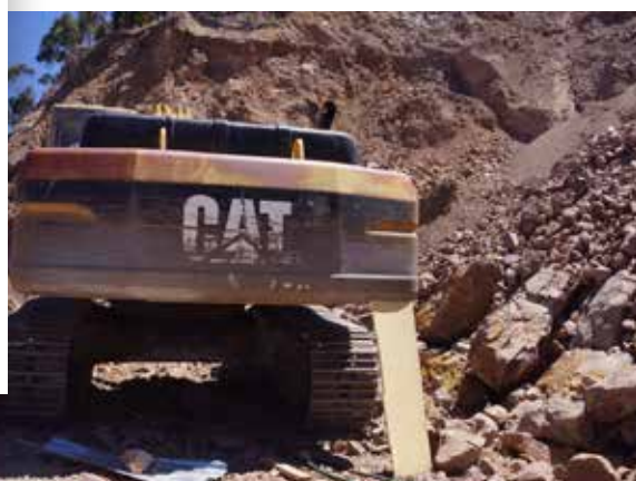
Foto 9. Maquinaria desmantelada en la obra.
