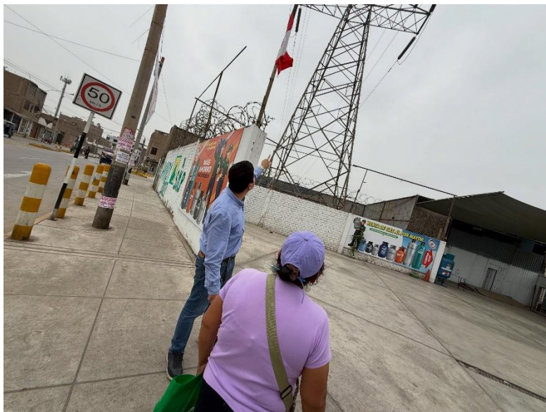
Inspección de la Torre 12 de alta tensión de la Av. Las Torres, ante los riesgos de seguridad advertidos por los vecinos de la zona.
